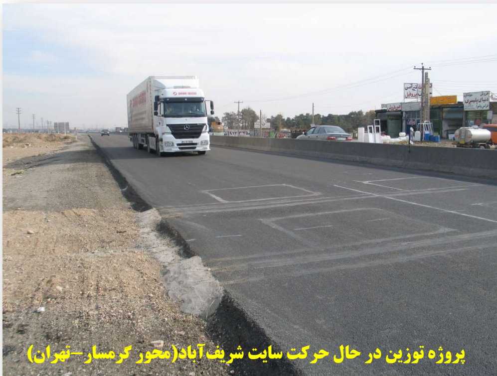
شکل ۳ نمایی از سامانه توزین در حال حرکت نصب شده در سایت شریف آباد (محور گرمسار - تهران)
