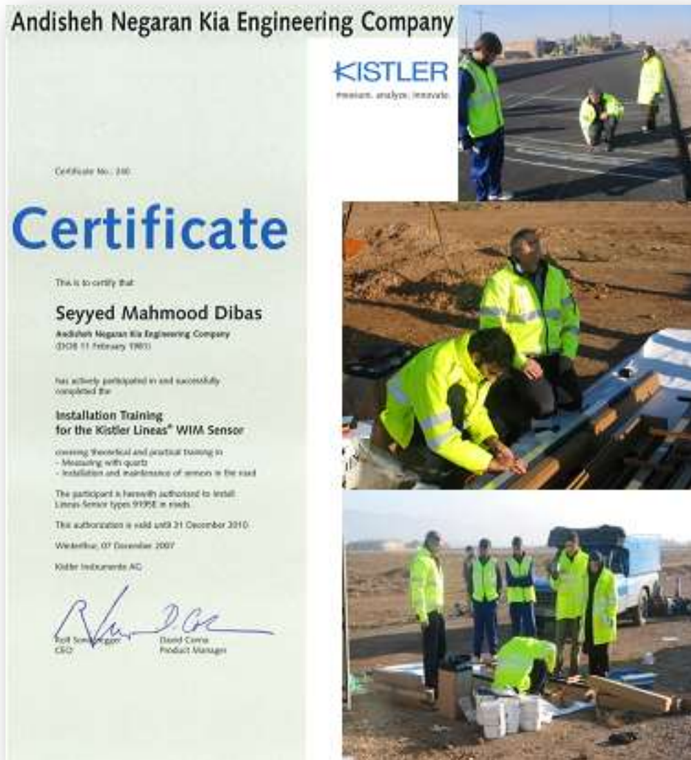
شکل ۵ مراحل نصب سامانه توزین در حال حرکت (WIM) توسط متخصصین شرکت و گواهی کسب شده از شرکت KISTLER سوئیس
